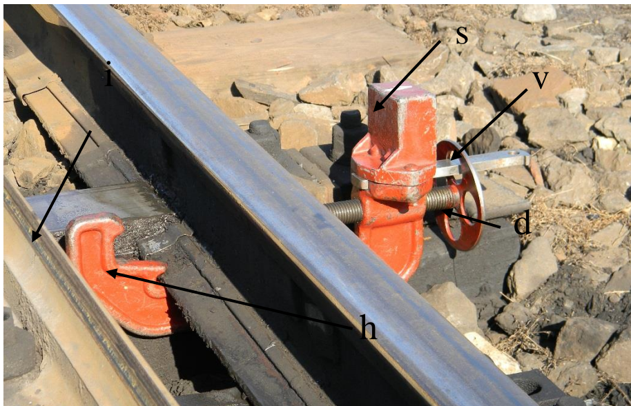
Rys. 2 Zabezpieczenie iglicy odsuniętej
