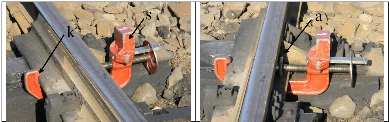
Rys. 3 Zabezpieczenie iglicy dosuniętej
